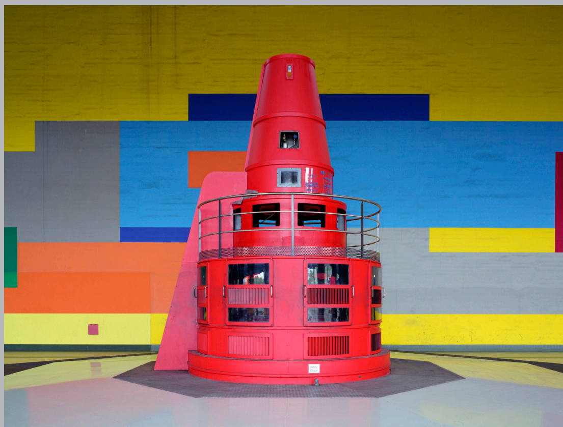
© Thomas Jorion, sans titre, Image électrique, 2015 (lieu : centrale hydroélectrique de Marckolsheim)
